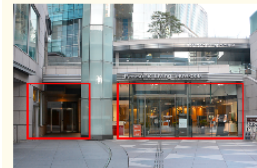
(左) 地下2階駐車場入口 (右) ショールーム入口
